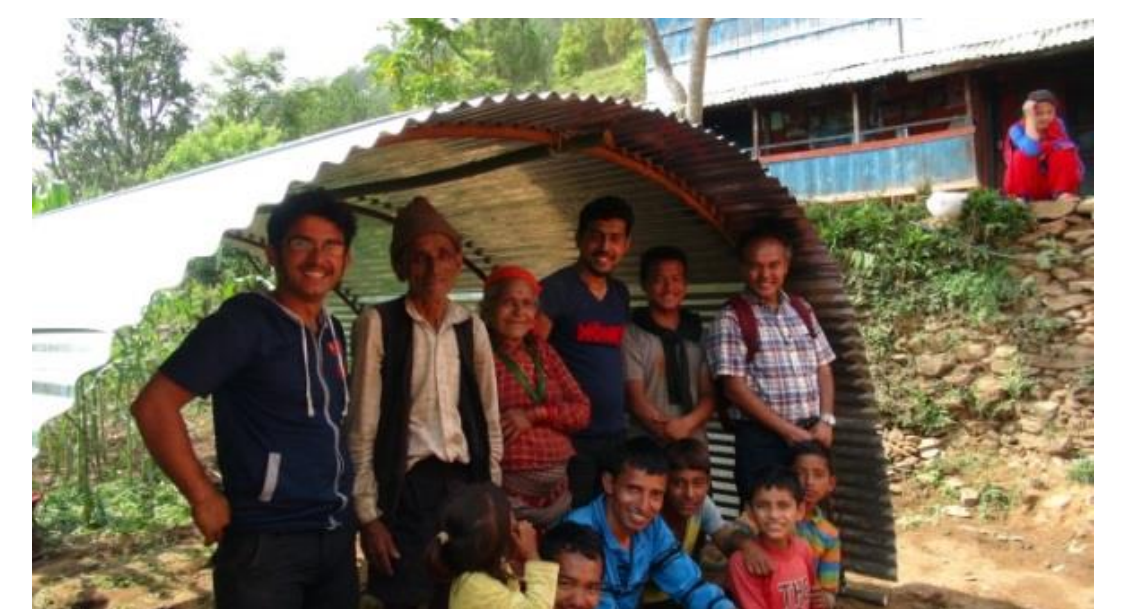
5軒のかまぼこ形仮設住宅の建設
