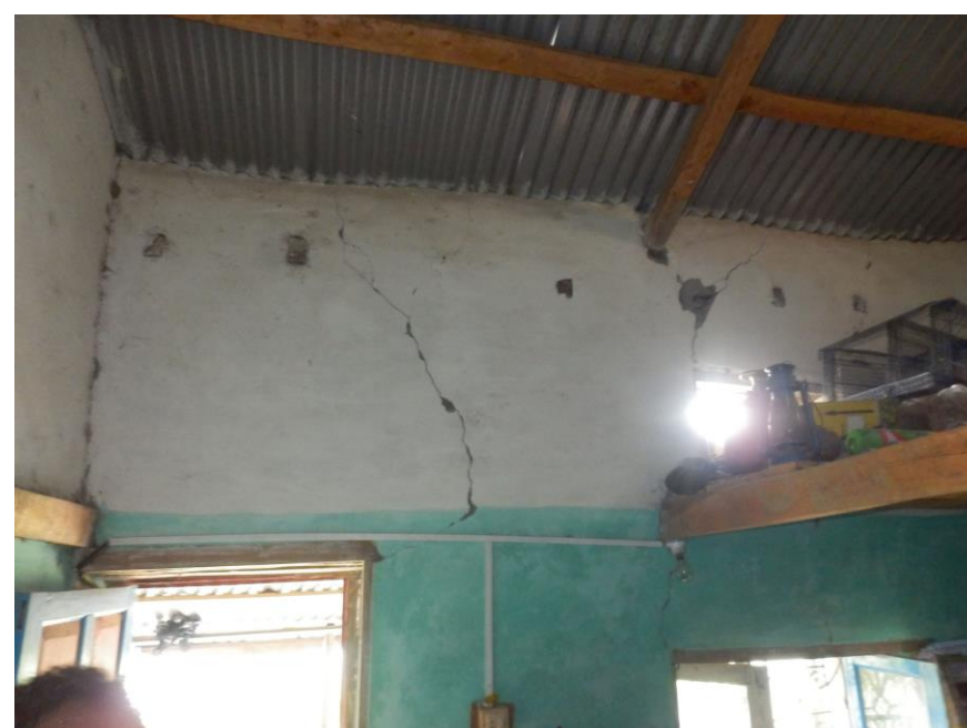
ほぼ全壊したサツレ村の家屋と家の中に見られるひび割れ
