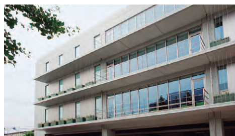
新1号館外観 水蓄熱利用の空調施設に加え、太陽光発電の装備や屋上・壁面緑化などを採用しました
