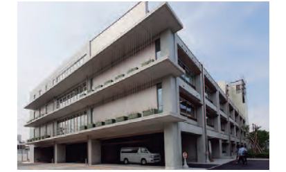
2011年12月竣工の新しい1号館南側(世田谷キャンパス)
